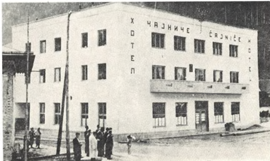
ZGRADA HOTELA U ČAJNIČU SA ČIJEG JE BALKONA TITO GOVORIO BORCIMA 2. PROLETERSKE BRIGADE 1. MARTA 1942.
